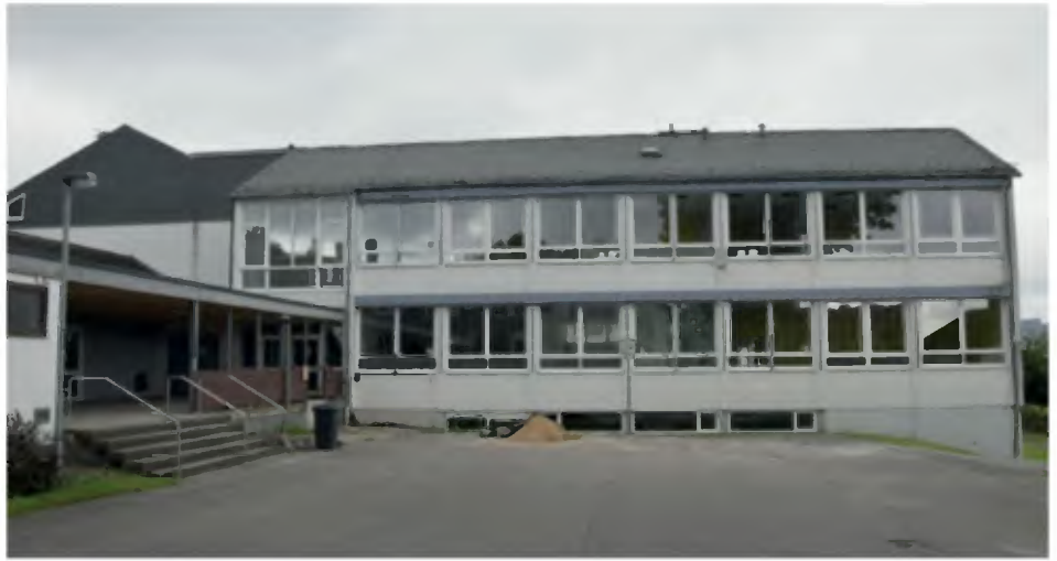
Zum Foto: Die alte Schule in Schönau wurde saniert und teilweise umgebaut. Hier findet die Musikschule der Gemeinde Wenden ein neues Zuhause.
