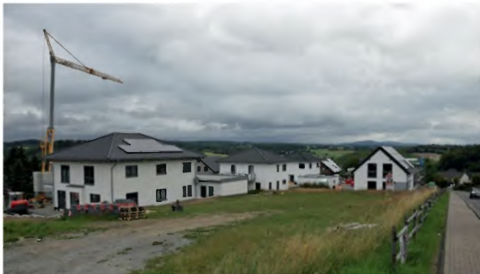
Zum Foto: Die Obstwiese in Wenden ist bereits weitestgehend bebaut. Mit einigen Mehrfamilienhäusern soll auch hier „bezahlbarer“ Wohnraum geschaffen werden.
