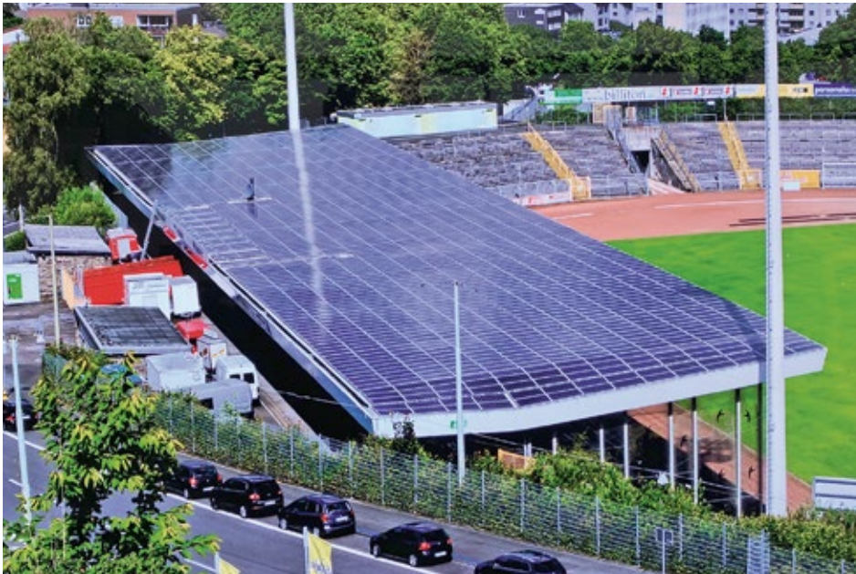
Zum Foto: Sehenswert! 2015 wurde eine Photovoltaikanlage mit 500 kWp auf dem Dach des Leimbachstadions in Siegen realisiert.
