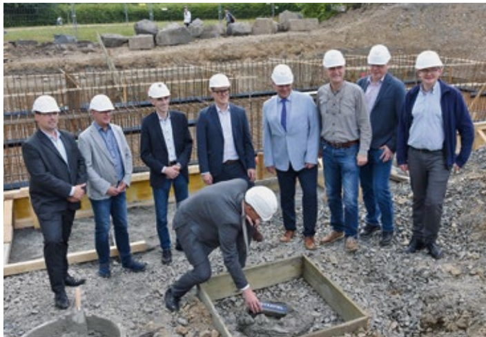
Zum Foto: Bürgermeister Bernd Clemens legte die Zeitkapsel in das vorbereitete Betonfundament.
