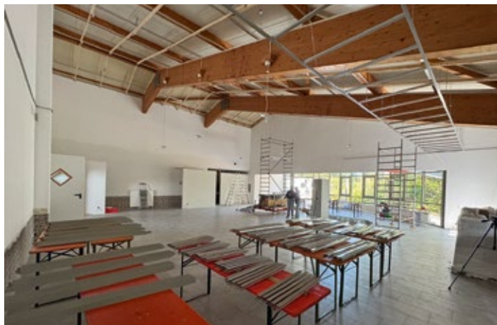
Zum Foto: Das Abhängen der Decke im Foyer war mit einem großen Aufwand verbunden.
